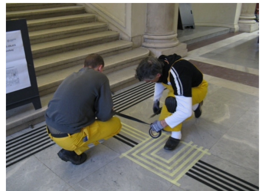
Abbildung 1: Anbringung des Bodenleitsystems im Hauptgebäude
